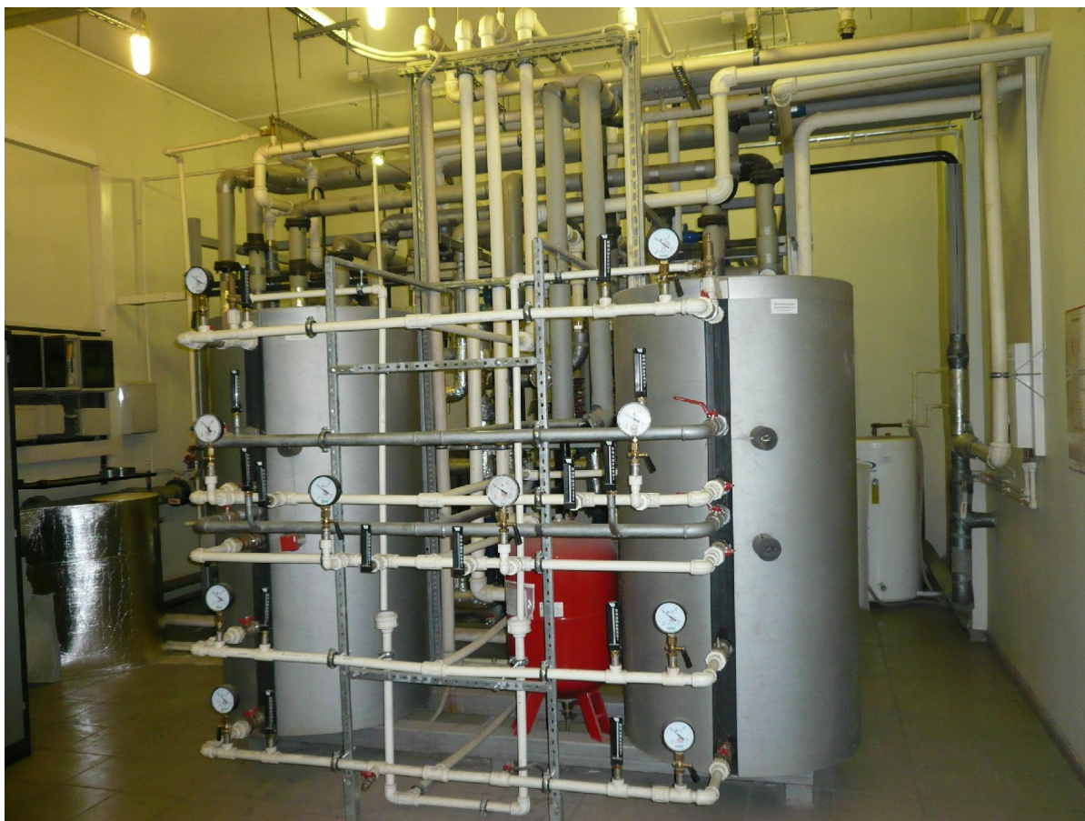
Автоматизированный тепловой пункт
