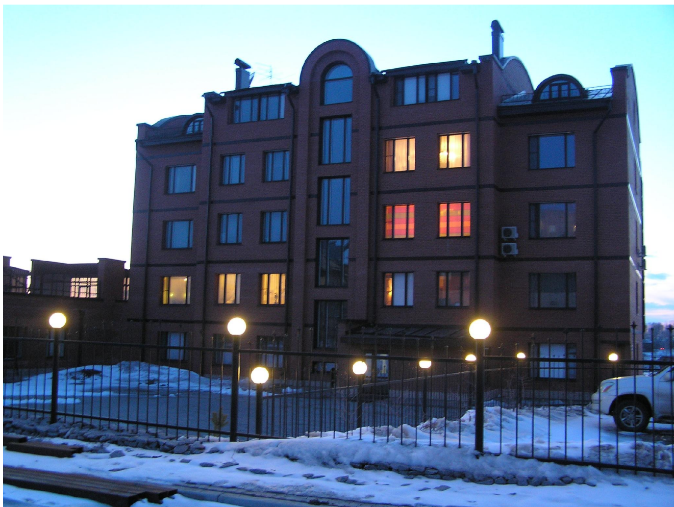
Внешний вид жилого дома
